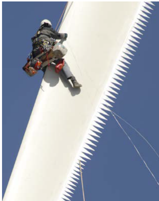
Figura 4 – Bordo de fuga serrilhado de uma pá eólica (extraído de [21])
